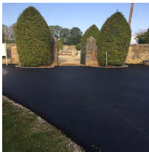
Ci-dessus et à gauche : les travaux de voiries 2021 – rue de la Perrière et rue du cimetière avant/pendant/après.
