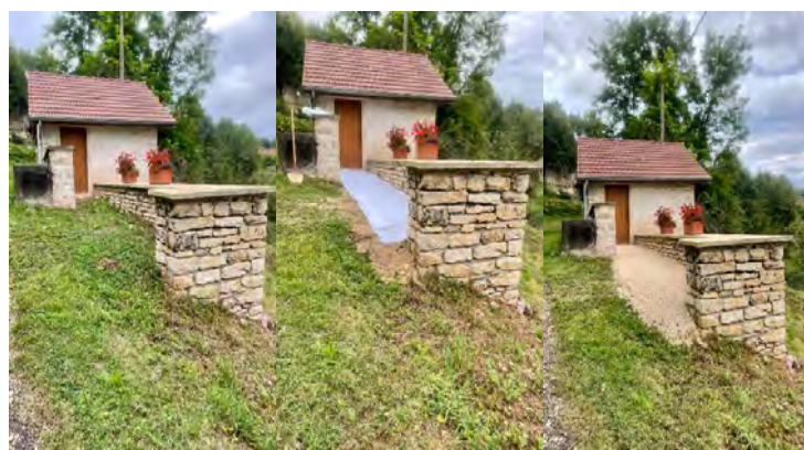
Ci-dessous : outre son fleurissement, le chemin d'accès à l'entrée du lavoir de la Villière fait peau neuve.
